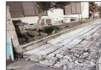
地震により倒壊したブロック塀
