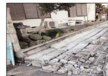
地震により倒壊したブロック塀
