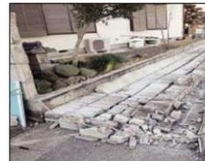
地震により倒壊したブロック塀
