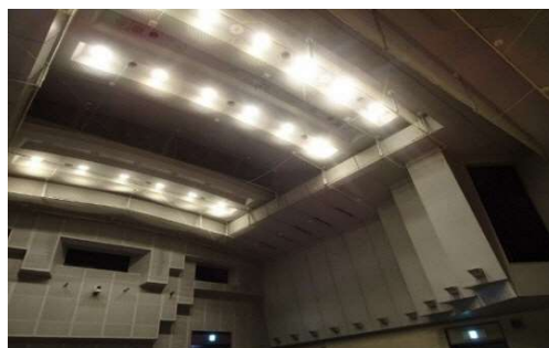
[つつじホールの天井部分]
