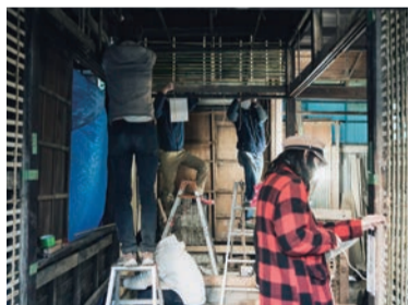
有志たちが集い土壁再生を行った。
