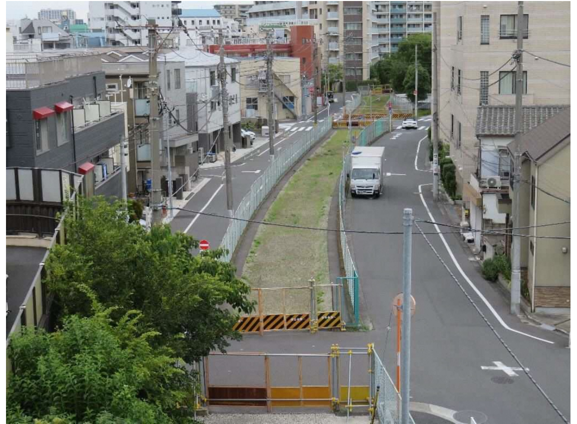
⑫南大橋上からの計画地全景
