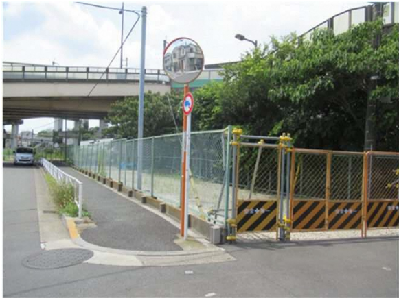
① 南端部（第1エリア）歩道に接する
