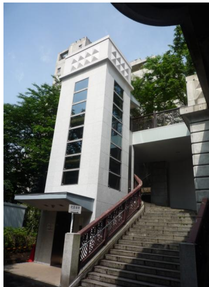
階段とエレベーター建屋
