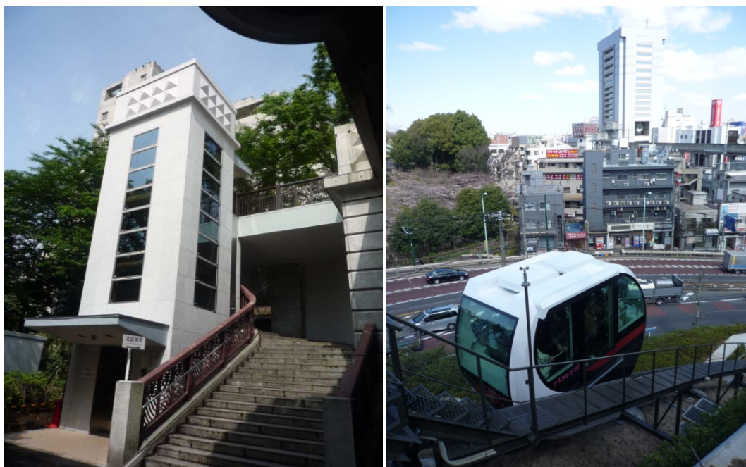
音無橋脇昇降施設(エレベーター) アスカパークレールのアスカルゴ
