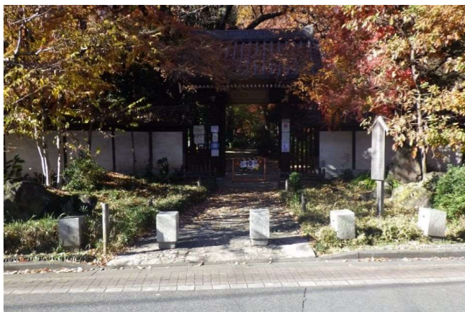
現況写真 (薬医門前)
