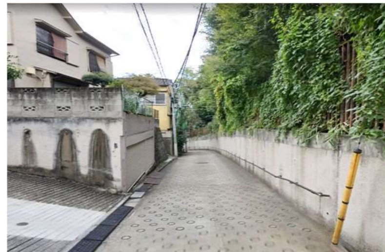
現況写真（三平坂 高台側より）
