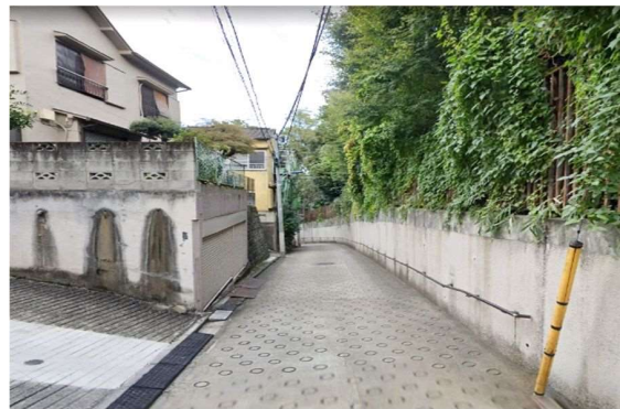
現況写真（三平坂 高台側より）
