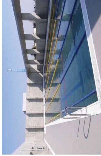
+ プール 日射を遮るための庇を設置しています。プールの水は災害時の消防水利、マンホールトイレ用水として利用します。
