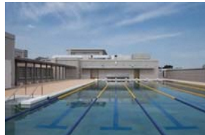
プール 4F 遮熱シート貼で快適なプールサイドを備えた25mプールです。災害時の消防用水、マンホールトイレ排水にも活用します。
