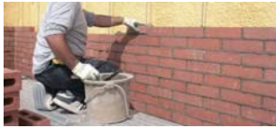
外壁中アレンガ積み (施工写真) 外壁仕上げは外断熱を基本としました。開口部は後部エコガラスで断熱性能を確保しています。
