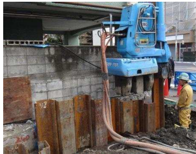
シートパイルの圧入
