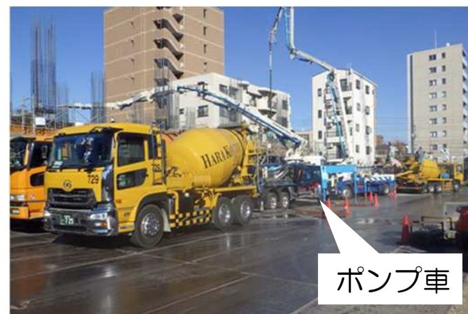
ミキサー車で搬入したコンクリートをポンプ車で圧送します
