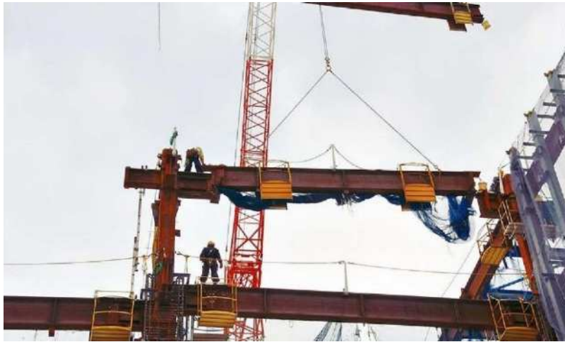
鉄骨組立て作業のイメージ
