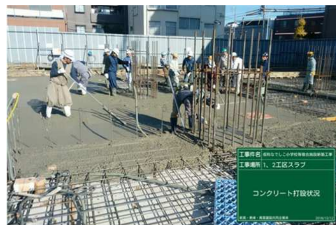
流し込んだコンクリートを均一に均します
