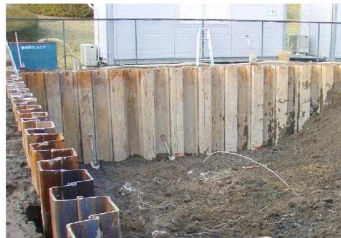
山留の内部を掘削
