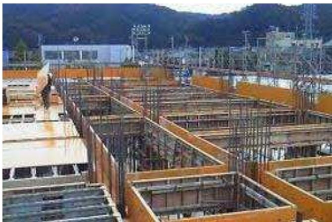
コンクリートを流し込む型枠を組み立てます
