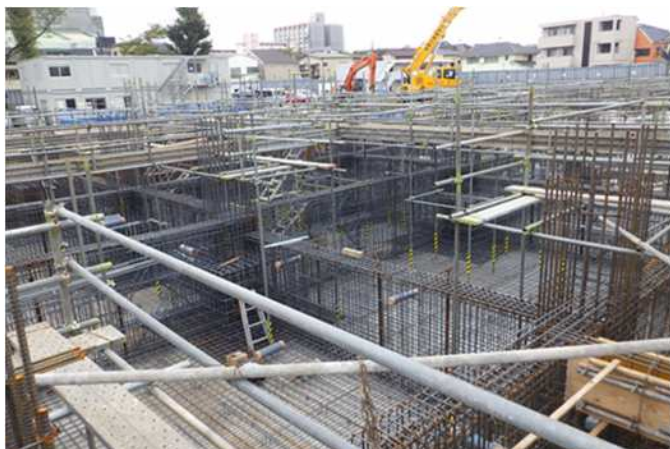
柱・梁・壁・床などの鉄筋を配置します
