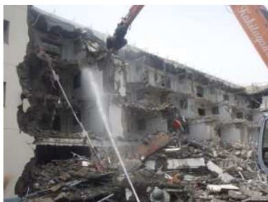
散水しながらの解体作業
