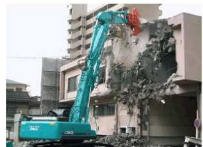
圧碎機による解体作業
