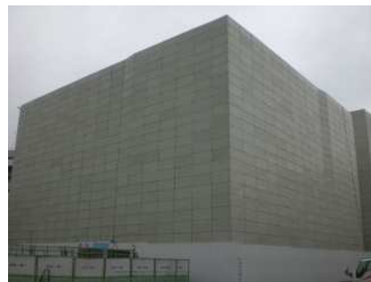
防音パネル張り
