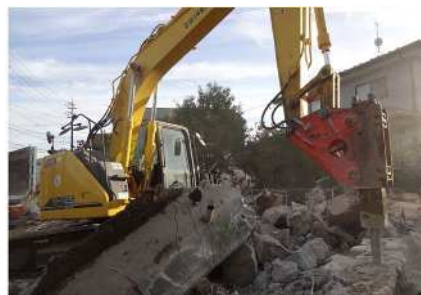
ブレイカー(破碎機)による 解体作業
