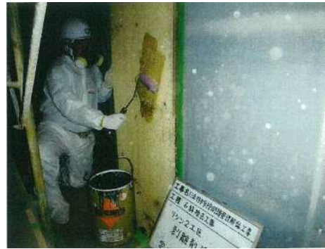
② 剥離剤塗布
