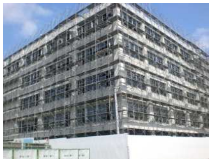
建物周囲に足場を設置
