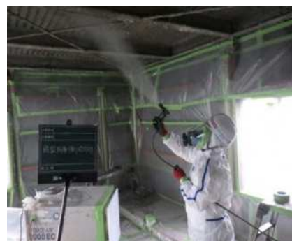
② 飛散抑制剤吹付
