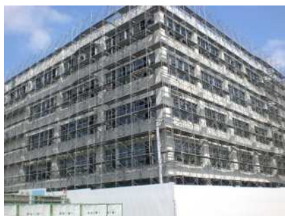
建物周囲に足場を設置
