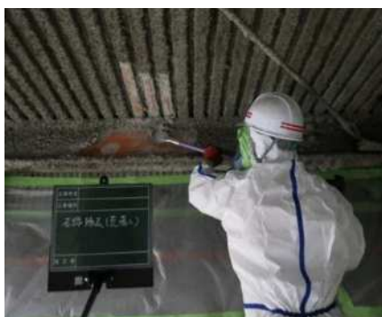
③ 石綿除去
