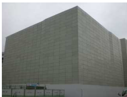
防音パネル張り
