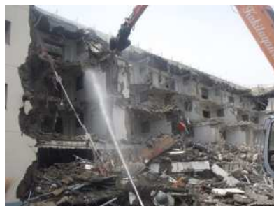
散水しながらの解体作業
