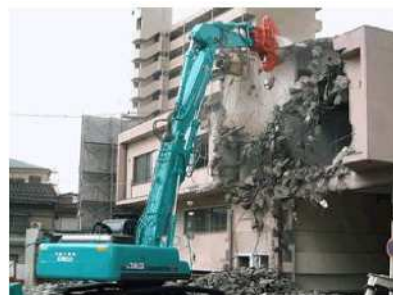
圧碎機による解体作業
