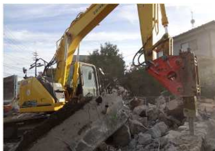
ブレイカー(破碎機)による 解体作業
