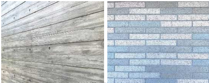
陰影のある段付杉板型枠コンクリート 桜や緑をイメージした「せっき器質タイル」
