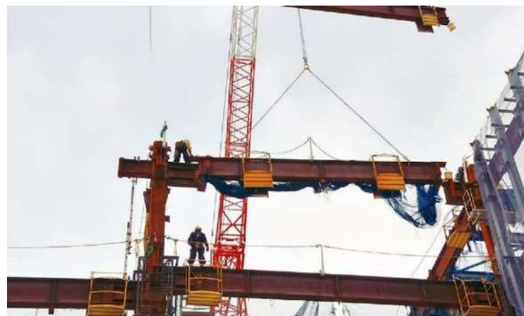
鉄骨組立て作業のイメージ
