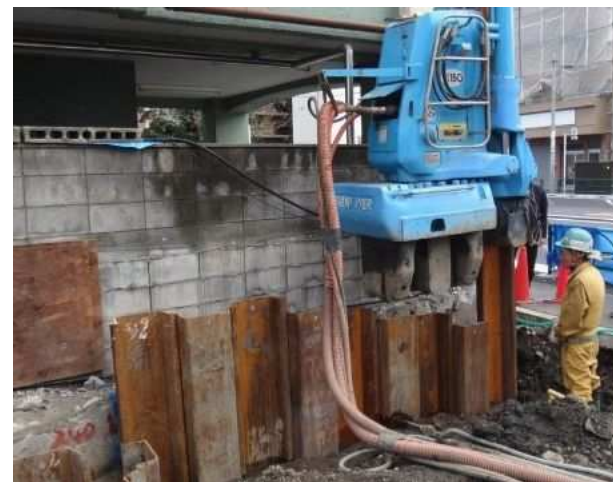
シートパイルの圧入（静音工法）
