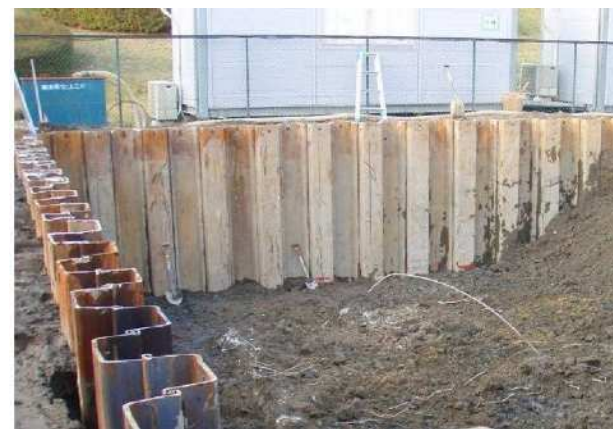
山留の内部を掘削
