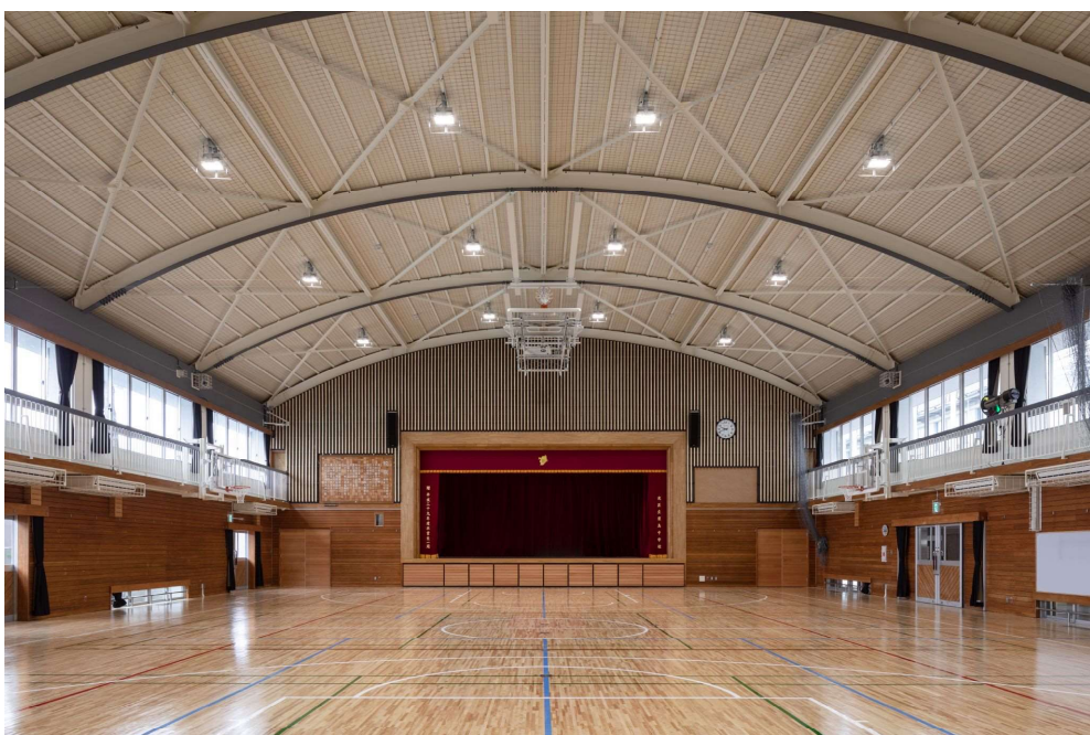
■体育館 前面と背面の壁に木のルーバーを取り付け、内装のデザインを一新しました。天井の断熱、空調の整備、床の改修、スロープの設置等により、快適性を向上しつつ、避難所機能も充実しました。
