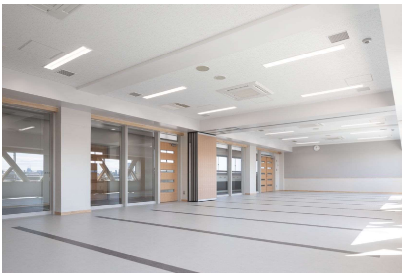
■夢あすか (多目的ホール) 教室間の壁を取り除き2教室分の広さを確保しました。防音機能のある可動間仕切りを設置し、多様な活動にも対応できる設えとしました。
