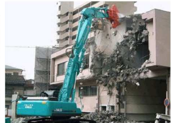
圧砕機による解体作業
