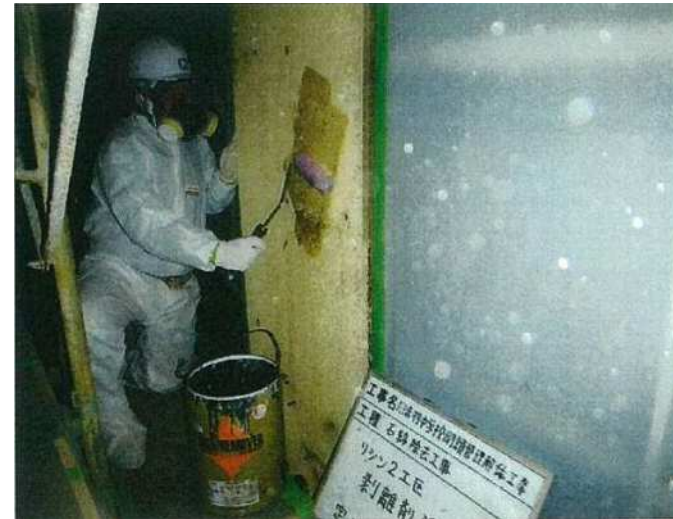
② 剥離剤塗布
