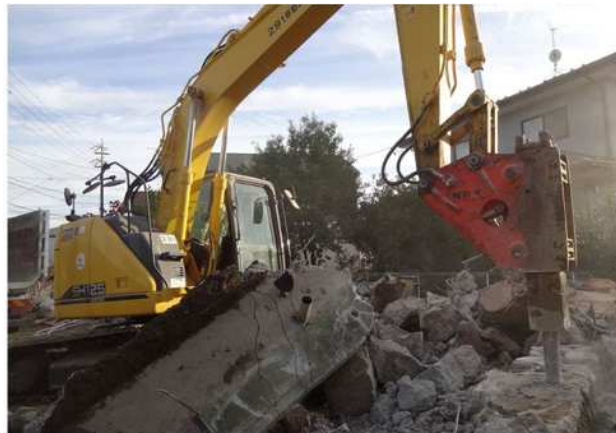
ブレーカー(破砕機)による 解体作業
