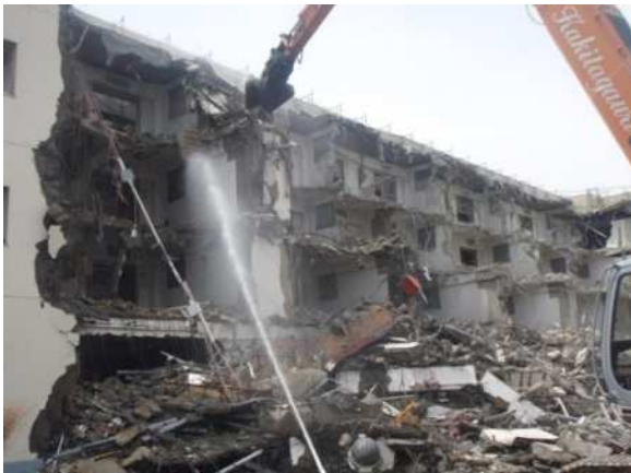
散水しながらの解体作業
