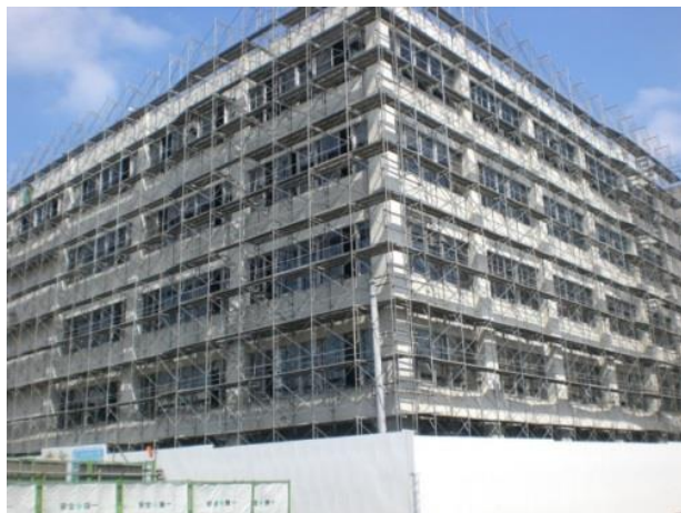
建物周囲に足場を設置
