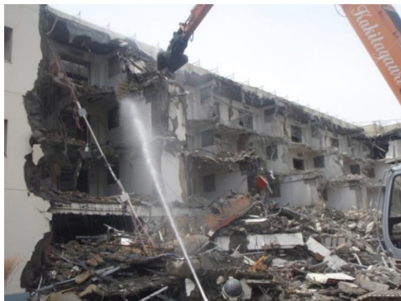
散水しながらの解体作業
