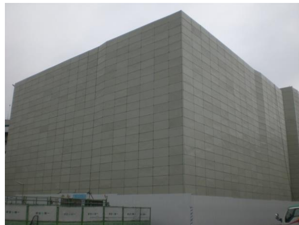
防音パネル張り
