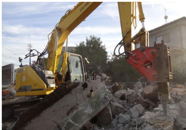
ブレーカー(破砕機)による 解体作業
