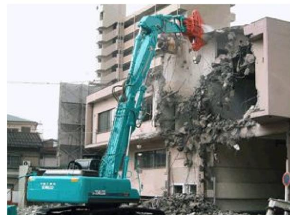
圧砕機による解体作業
