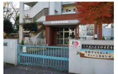
旧浮間子ども・ティーンズセンター
