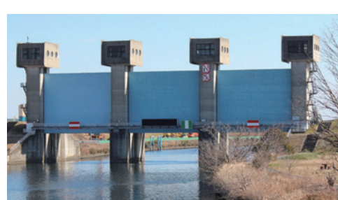
首都東京を水害から守る岩淵水門
