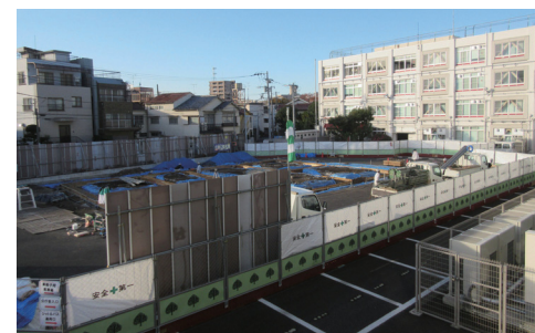
分庁舎に建設中の保育園
