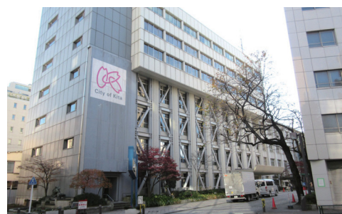
耐震改修後の本庁舎
