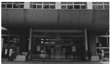
昭和35年建築の区役所第一庁舎
