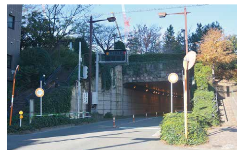
赤羽台トンネル
