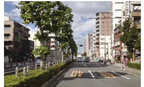
無電柱化されている赤羽東本通り
