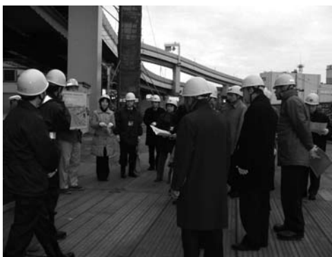
溝田橋架替・石神井川付替工事現場を視察
