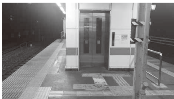
鉄道駅エレベーター
