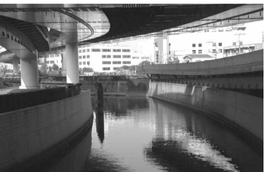
石神井川（堀船地区）
