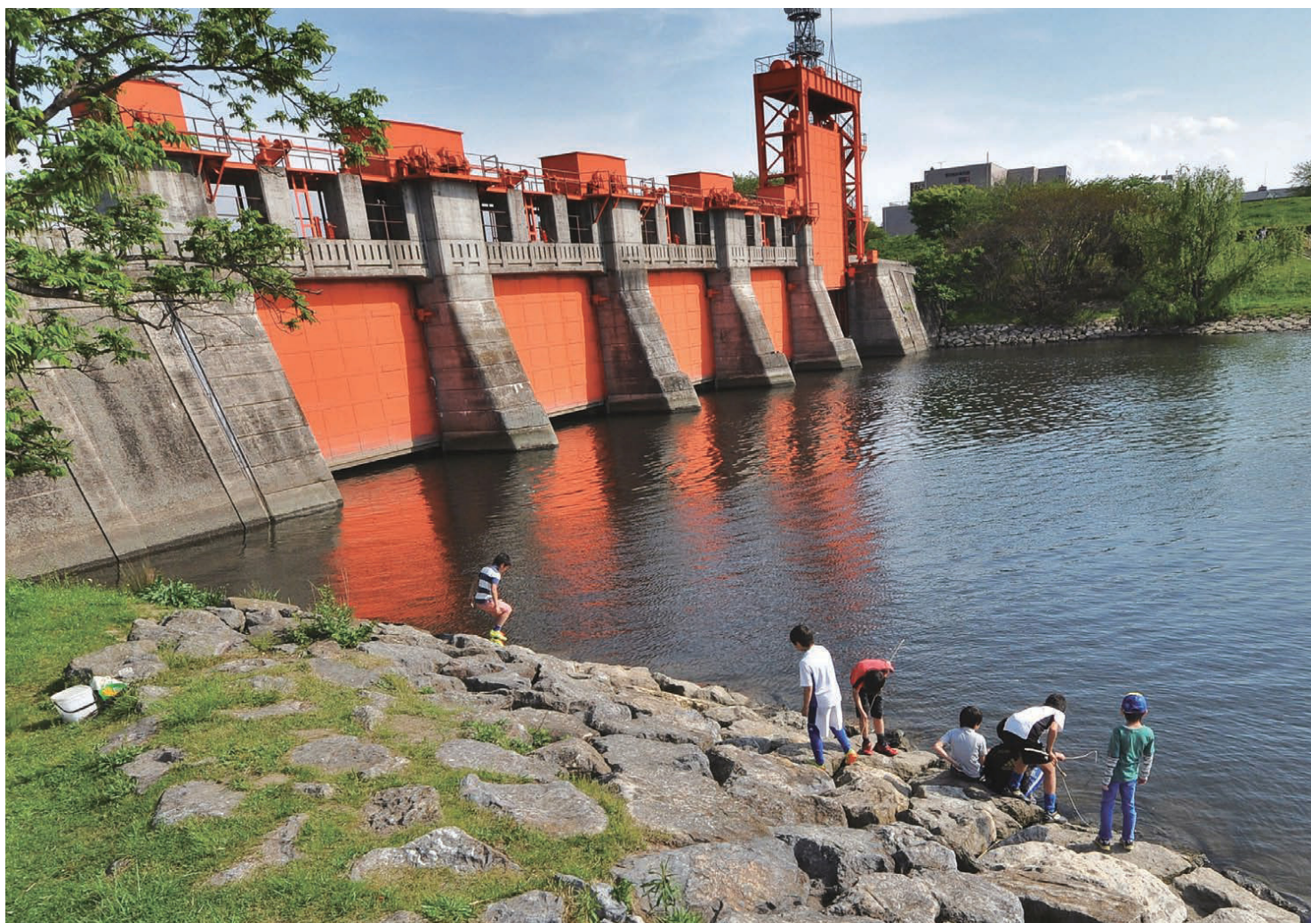
「子供達のオアシス」旧岩淵水門
