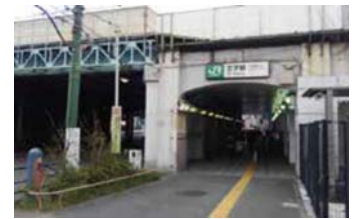
山の下架道橋
