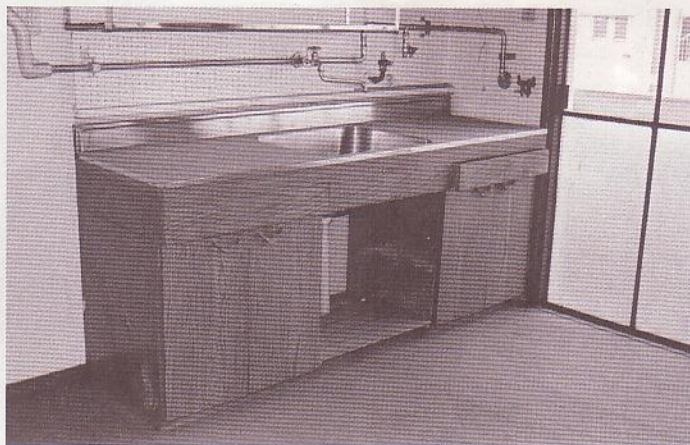
赤羽台団地完成時に設置されたステンレス流し台
