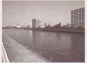
梶原の渡し場付近。対岸はマンションや工場が林立しています。
