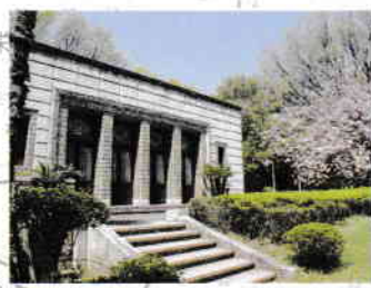
渋沢栄一へのビックな贈り物 旧渋沢家飛鳥山邸(晚香廬・ 青淵文庫)
