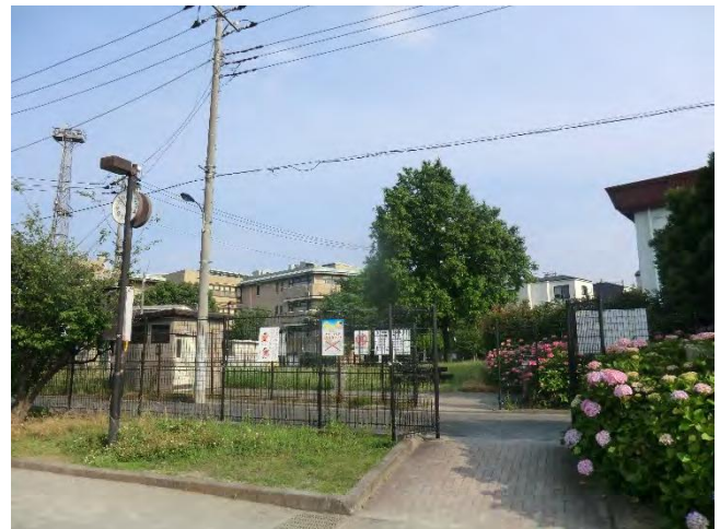
⑥ 照明灯、入口
