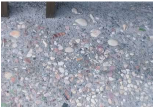
コンクリート舗装（貝殻入り）
