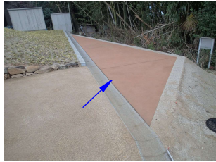
カラーサンド舗装（透水性高炉スラグ舗装）
