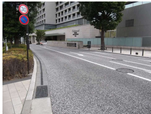
景観舗装（ビューテックス）
