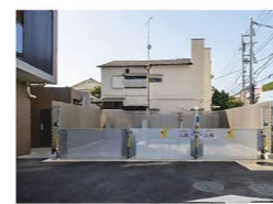
機械式駐車場
