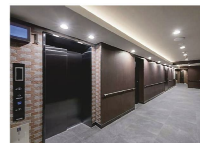
ELV ホール・共用廊下
