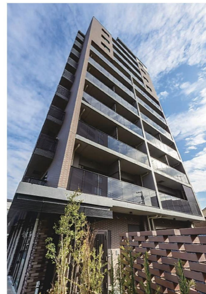
外観 北西面 見上げ
