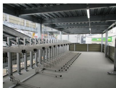
仮設自転車駐車場内部
