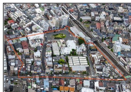
航空写真（解体工事開始前）
