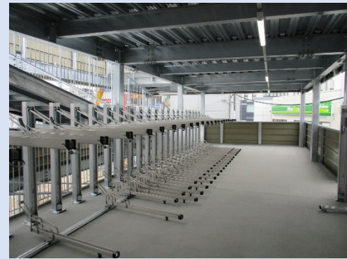
仮設自転車駐車場内部
