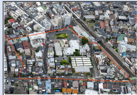
航空写真（解体工事開始前）
