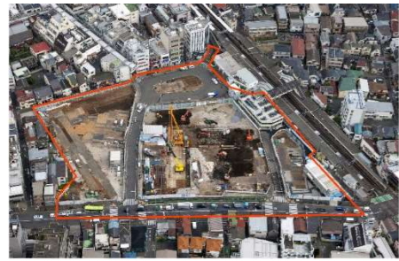
令和3年3月末（解体完了後）
