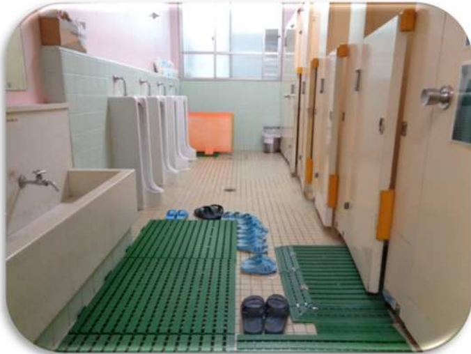
廊下手前のトイレ
