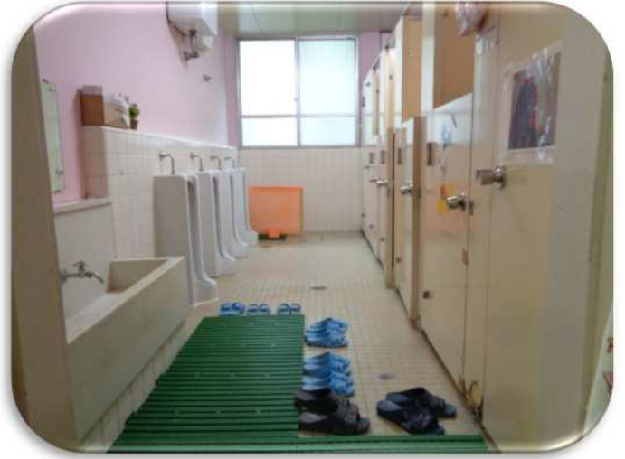
廊下奥のトイレ
