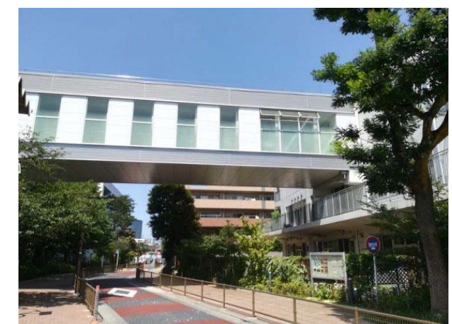
④2つの棟を繋ぐ渡り廊下
