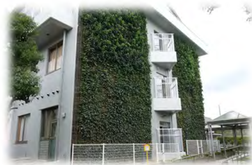
支持材を用いた壁面緑化
