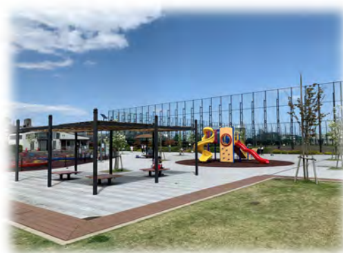
浮間水再生センターの上部空間を利用した新河岸東公園
