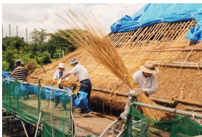
「区民ボランティアによる 古民家の茅葺き作業」
