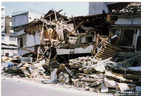
写真：倒壊した木造住宅（阪神・淡路大震災）
