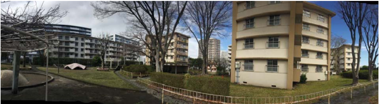
↑ 階段室型住棟 (41号棟)
