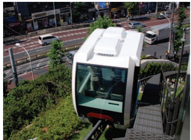
あすかパークレール アスカルゴ
