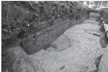
法倉跡(礎石下の土を搦き固められた版築)
