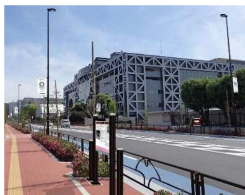
ROUTE2020 トレセン通り
