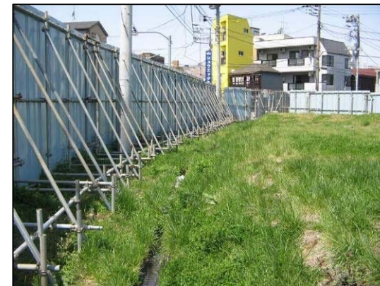
整備前の様子(H19年4月)
